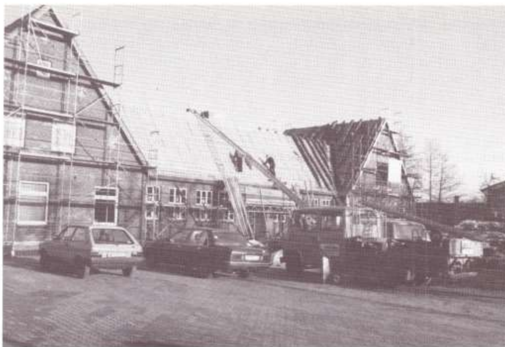
Dachernuerung der alten Schule 1990/91
