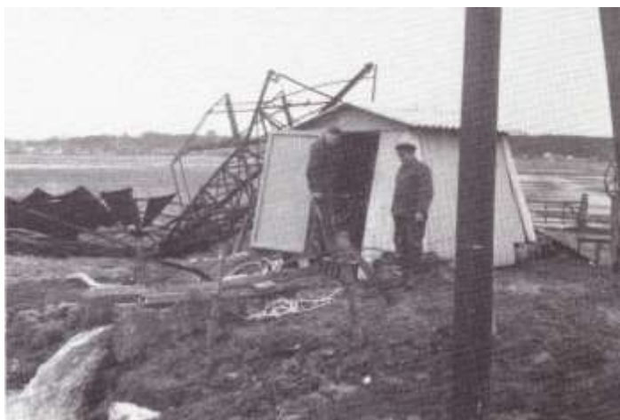
Die Umbauarbeiten 1969. Im Vordergrund Bauer Hermann Kruse aus Kuden mit einem Monteur.
