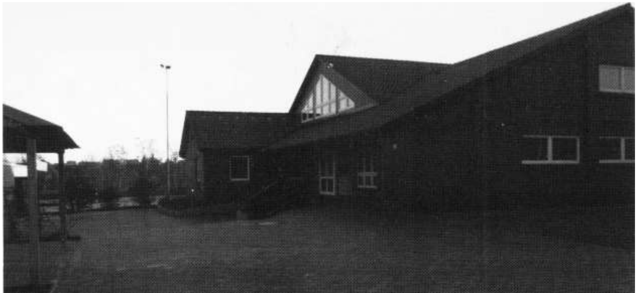
Neue Schule, Eingangsbereich
