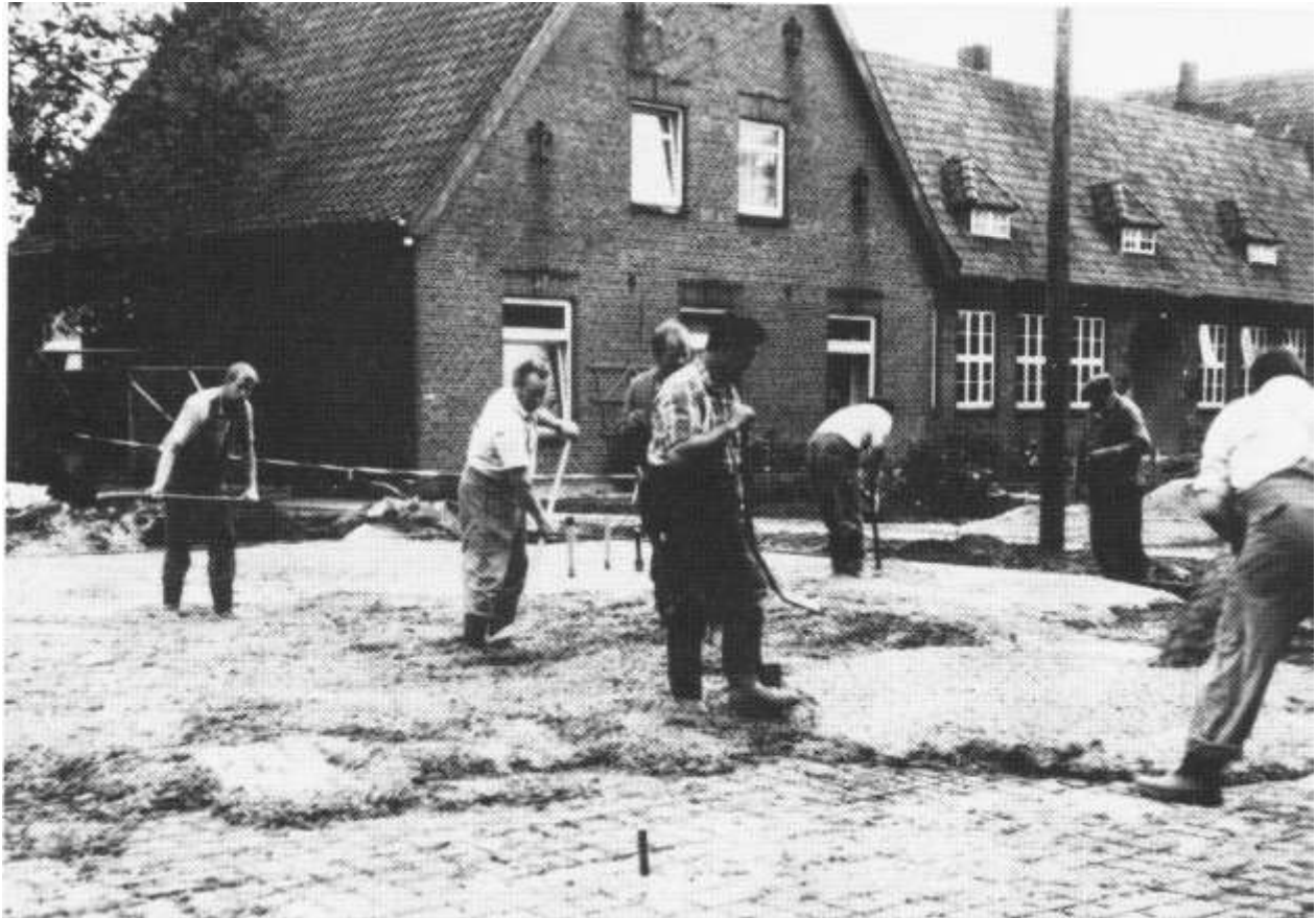
Feuerwehrkameraden bei Fundamentarbeiten 1984
