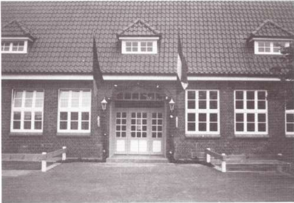
Die alte Schule nach der Renovierung, die Kudener „Begegnungsstätte“
