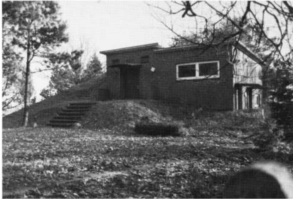
Das im Jahre 1956 errichtete Gebäude des Kudener Wasserwerks
