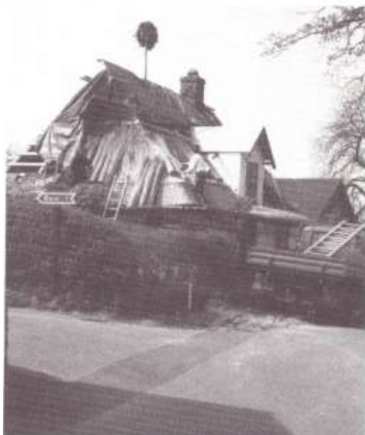
Reetdacherneuerung im Rahmen der Dorferneuerung 1990, Haus Knüll Nr. 4
